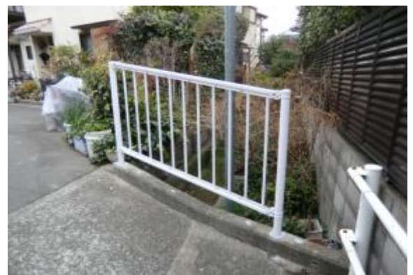
久代4丁目の橋に防護柵設置される
