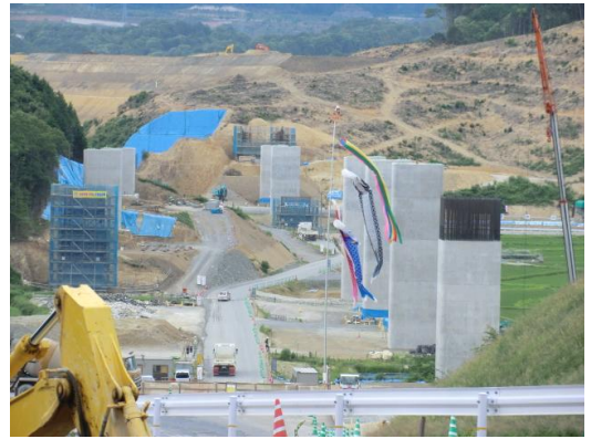
写真右・六石山トンネルからインターチェンジを見る 写真左・インターチェンジ付近
