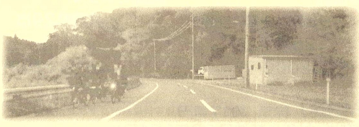
市道2190号、路側帯の中が狭く(写真右側)溝に蓋掛けがないため、逆走せざるをえない生徒
